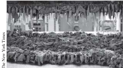
The New York Times ニューヨークの下水道管から取り除かれた、ウェットワイプのかたまり。写真は、2月19日、Newtown Creek Wastewater Treatment Plantで撮影
